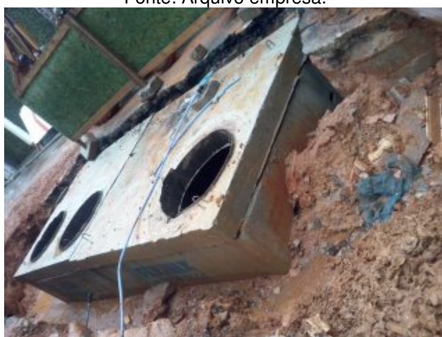
Figura 14 – Tampa da aduela finalizando o fechamento da caixa de abrigo.
