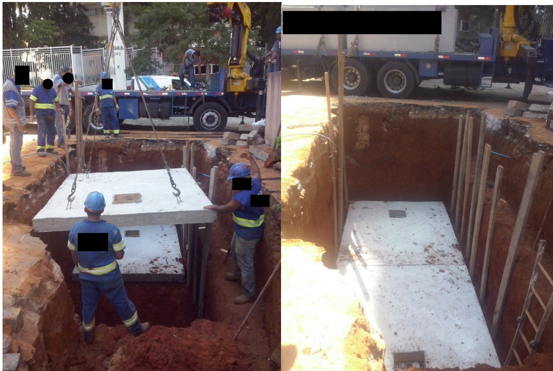
Figura 11 – Descida da aduela com auxílio de caminhão munk.
