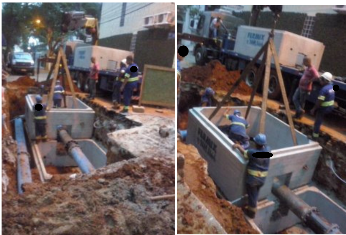
Figura 13 – Descida da aduela com auxílio de caminhão munk.
