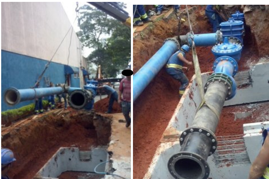
Figura 17 – Descida da VRP e By-pass. Fonte: Arquivo empresa.
