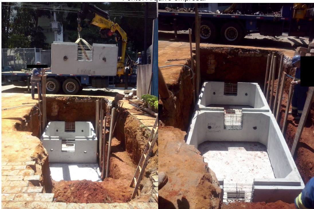
Figura 12 – Descida da aduela com auxílio de caminhão munk.
