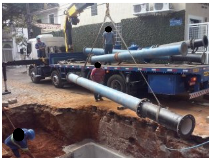
Figura 15 – Descida do 1º braço da VRP.
