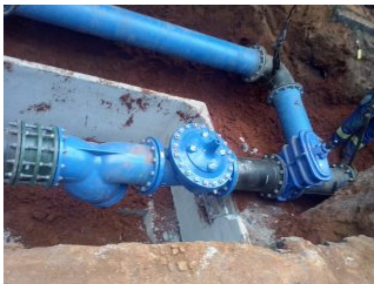
Figura 18 – Descida da VRP e By-pass. Fonte: Arquivo empresa.
