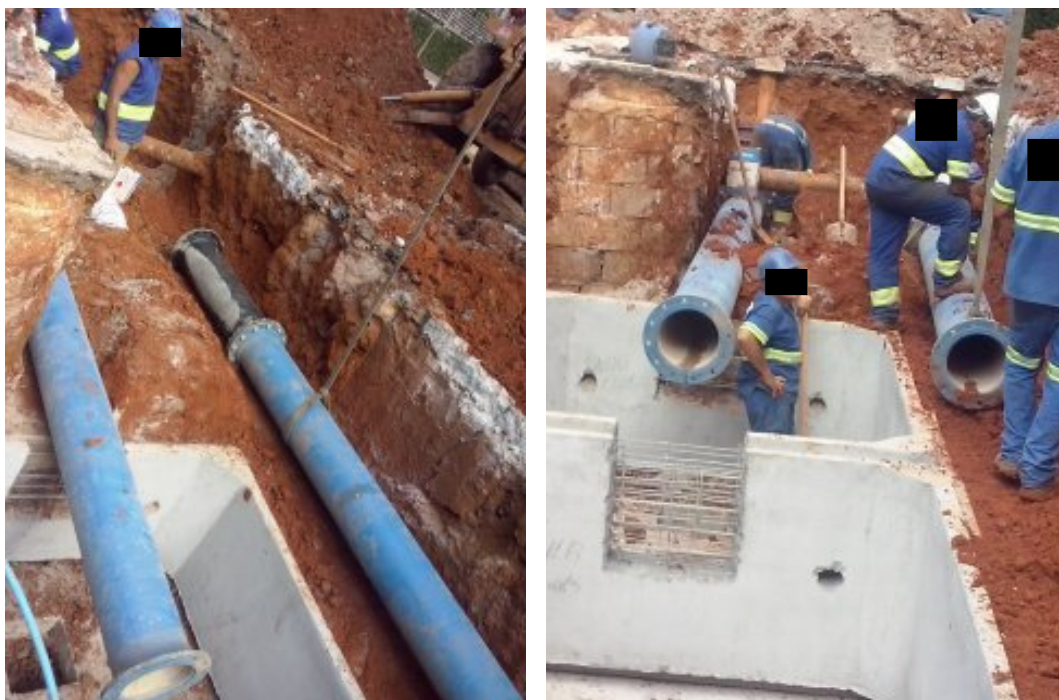
Figura 16 – Descida do 2º braço da VRP.
